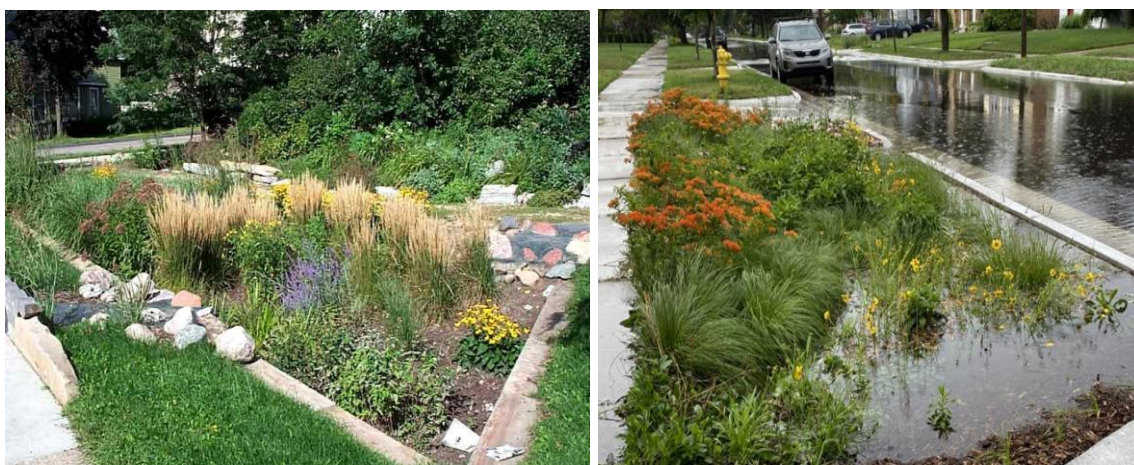
Slika 64. Primjer kišnog vrta uz prometnice
