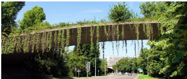
Slika 60. Primjer zelenog mosta u Stuttgartu
