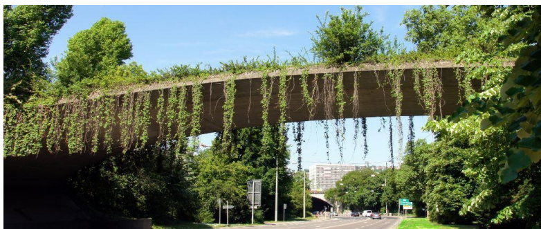
Slika 62. Primjer zelenog mosta u Stuttgartu
