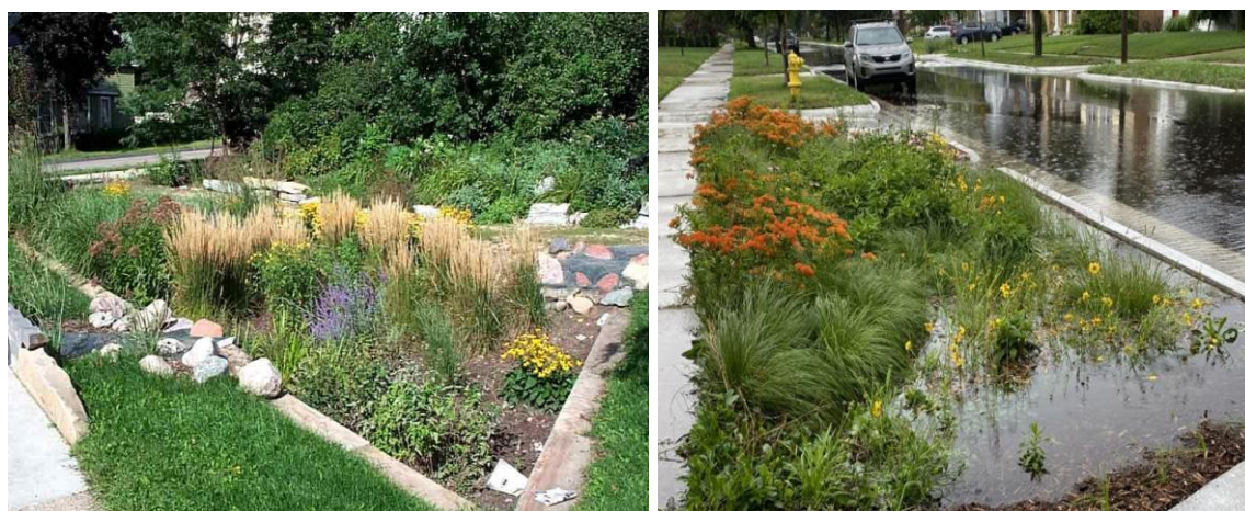
Slika 65. Primjer kišnog vrta uz prometnice
