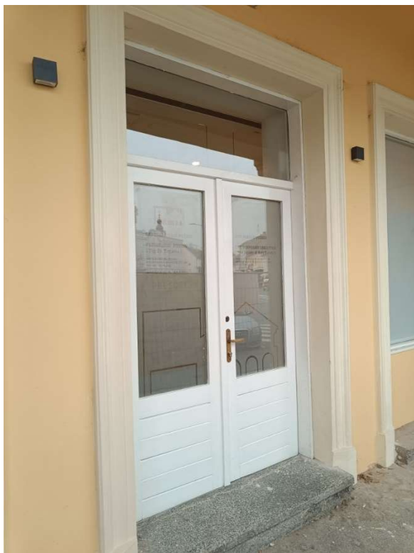
- ulazna vrata - pročelje
